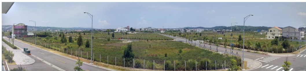
照片 14：龍椅段周邊全景現況
