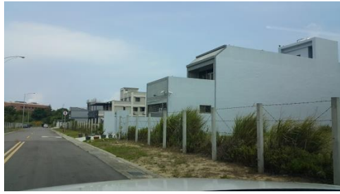
照片 1：龍頂段開發現況 1
