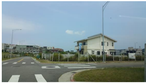
照片 3：龍頂段開發現況 3
